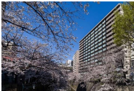
『イニシア板橋 桜レジデンス』外観
