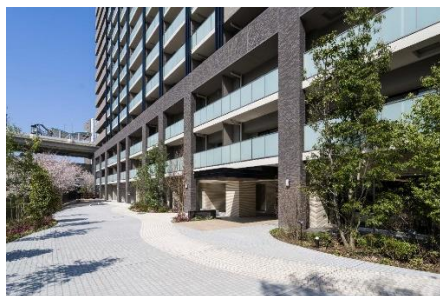
桜並木に面したエントランス前スペース
