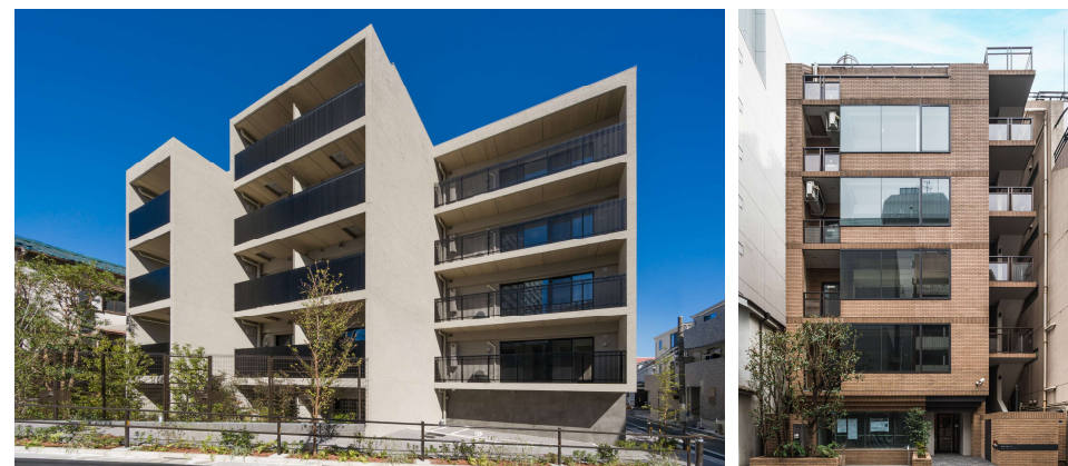
収益不動産 『コスモグラフィア板橋』
