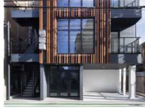
設計・施工事例 (三菱地所リアルエステートサービス株式会社 (仮称) 玉川3丁目新築工事)
