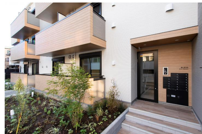
設計・施工事例 (BLESS新中野)
