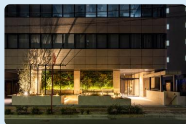
辰野新大阪ビル 共用部リニューアル
