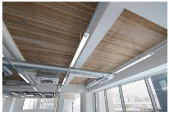
3階 専有部天井
